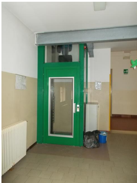
Esempio elevatore interno edificio
